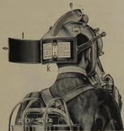
Fig. 1. Rauchhelm des Drägerwerks mit elektrischer Lampe.
