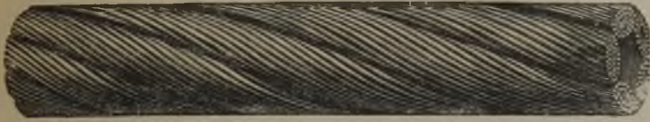
Fig. 3. Flachlitziges Seil.
