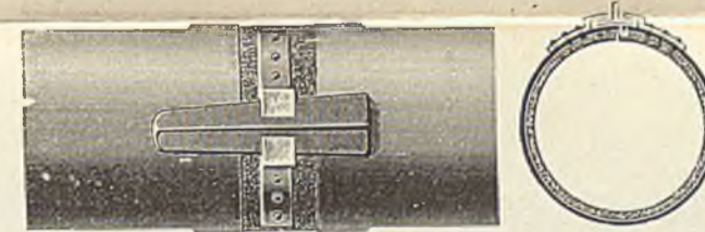
Fig. 12. Luttenverbindung mit Keilverschluss.
