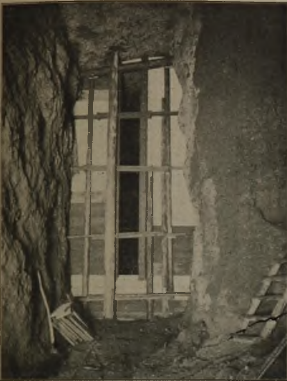
Abb. 24. Holzdamn zum Trennen der Erzmassen vom Sand.
