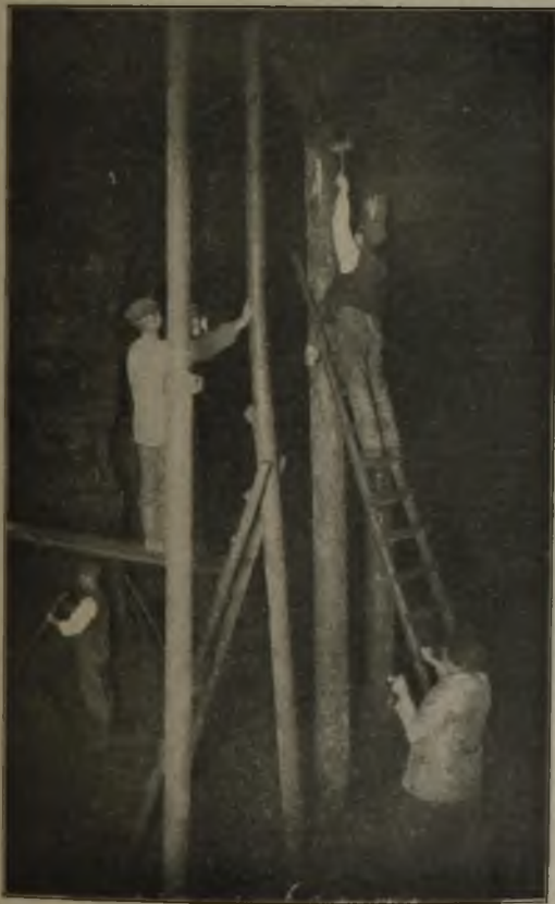
Abb. 25. Rauben der Stempel beim Pfeilerbau der Erzgrube Bülden-Adenstedt.
