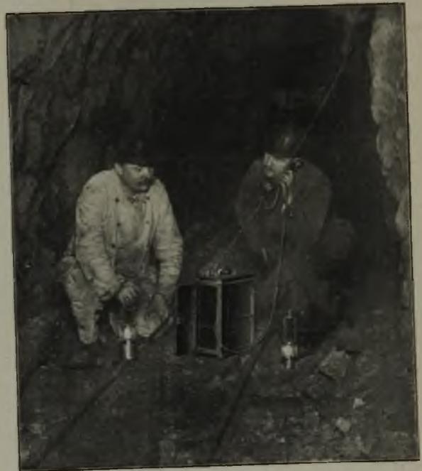
Abb. 11. Anordnung des tragbaren Telefons in der Grube.
