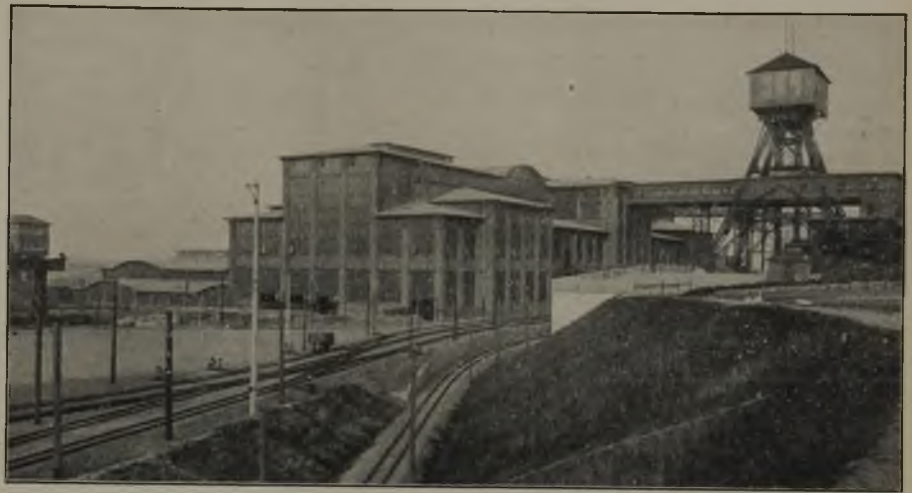
Abb. 2. Ansicht der neuen Förder- und Aufbereitungsanlage von Westen.
