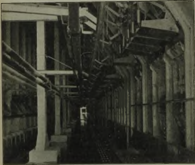
Abb. 10. Durchfahrt mit Abfuhrtaschen für Fertigerze (rechts) und für Zwischengut (links).
