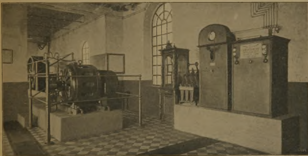
Fig. 14. Antriebmotor des Capell-Ventilators.
