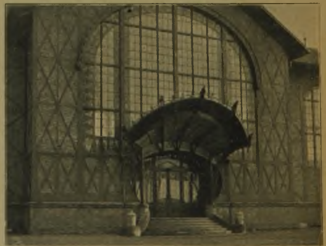
Fig. 8. Portal der Maschinenhalle.
