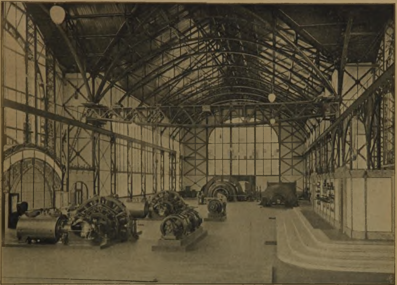
Fig. 9. Inneres der Maschinenhalle.
