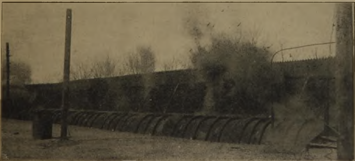
Fig. 1. Alte Versuchstrecke während einer Schlagwetter-Kohlenstaubexplosion.
