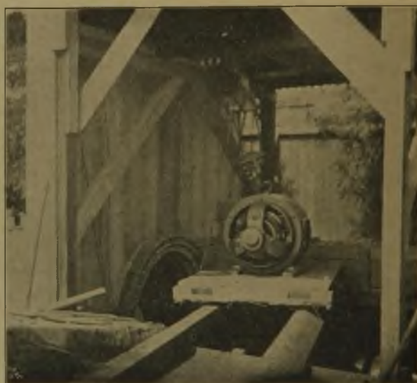
Fig. 2. Einhängen eines Motors in die Explosionskammer der alten Strecke.
