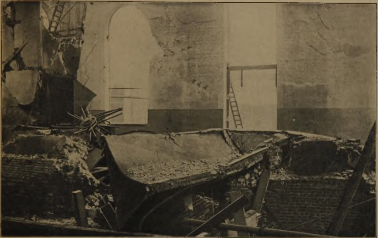
Fig. 4. Zerstörter vorderer Teil der Maschinenhalle.
