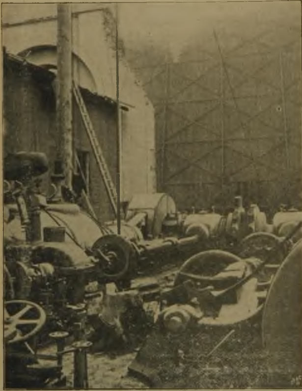
Fig. 5. Die zerstörte Dampfdynamo.
