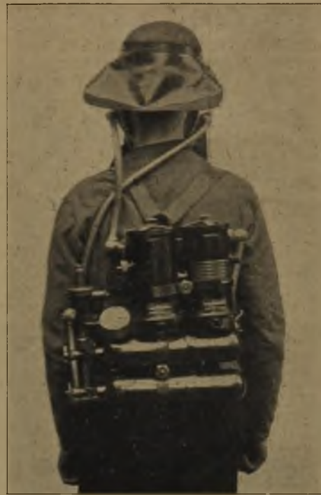
Fig. 5. Giersberg-Helmapparat, Rückansicht.
