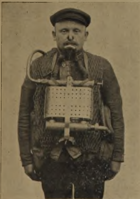
Fig. 11. Pneumatogen mit Luftzirkulation.
