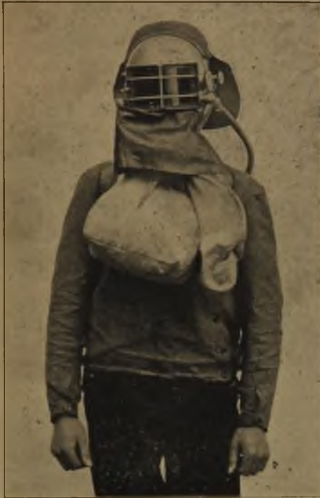
Fig. 4. Giersberg-Helmapparat, Vorderansicht.
