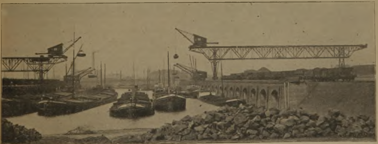
Fig. 1. Hafen von Walsum mit Kohlenverladebrücke (links), Erzverladebrücke (rechts) und Kranen.
