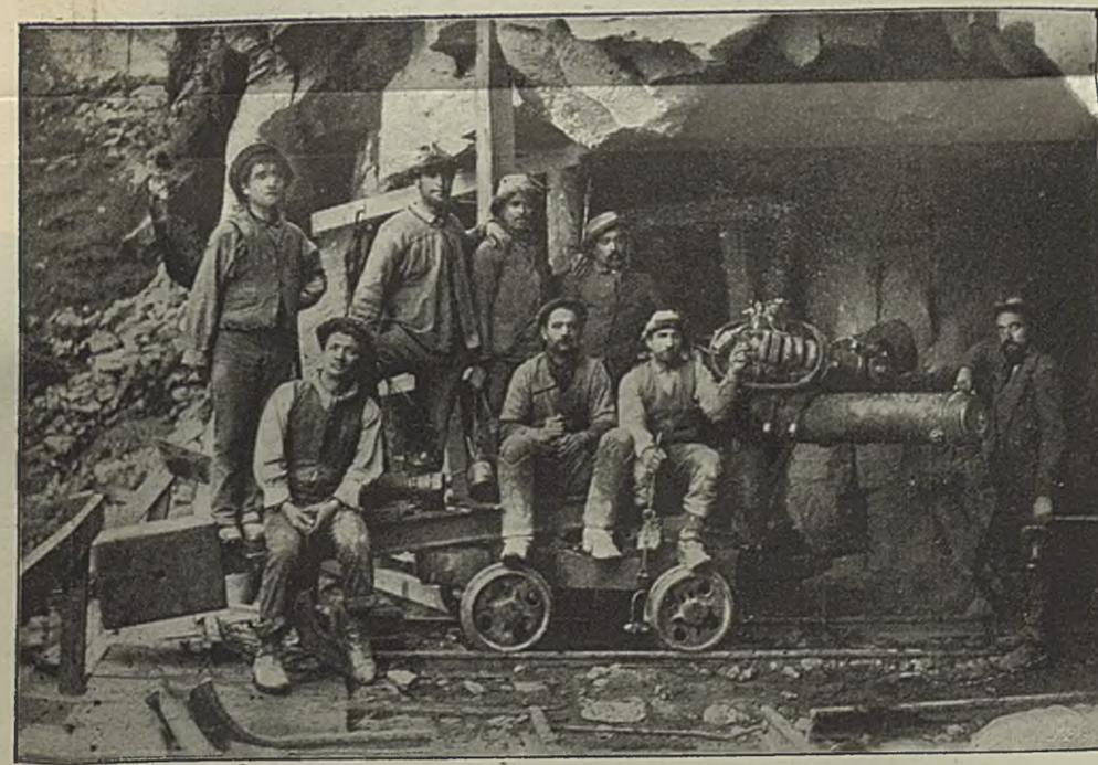
Fig. 7. Der Bohrwagen mit den Maschinen am Stollenmundloch.
