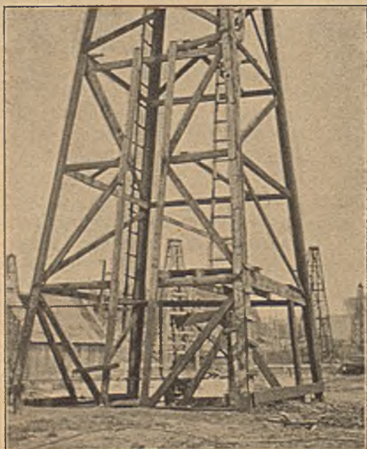
Fig. 6. Ansicht eines 6lschachtes.
