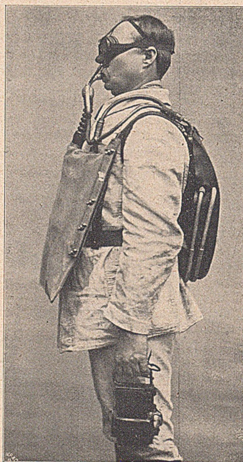
Fig. 10. Vorderansicht des Atmungsapparates der Sauerstoff-Fabrik, Berlin, Type 1904.
