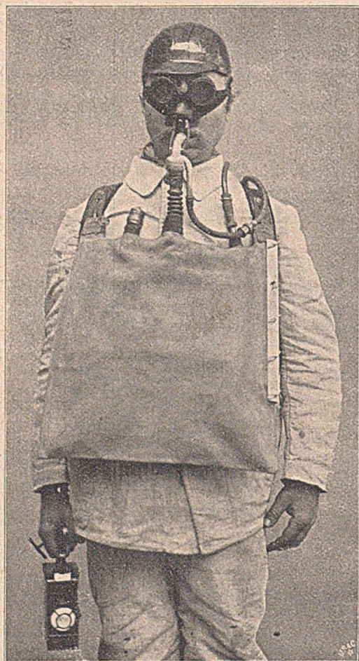
Fig. 10. Vorderansicht des Atmungsapparates der Sauerstoff-Fabrik, Berlin, Type 1904.
