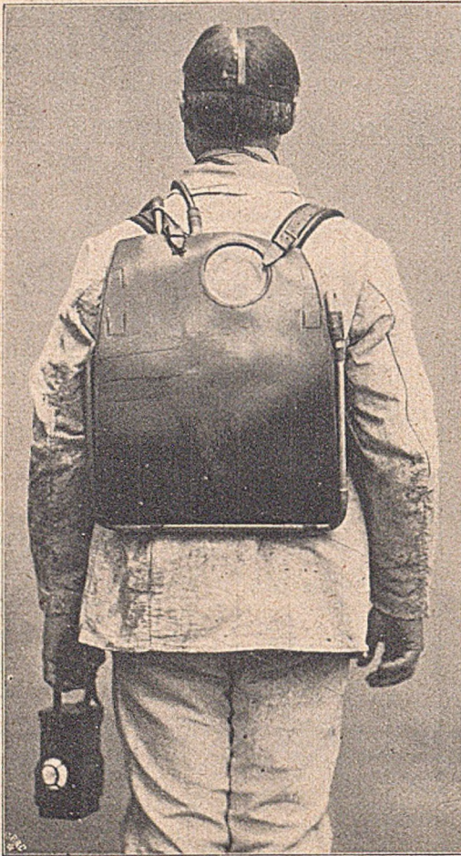
Rückenansicht des Atmungsapparates der Sauerstoff-Fabrik, Berlin, Type 1904 Fig. 13 mit
