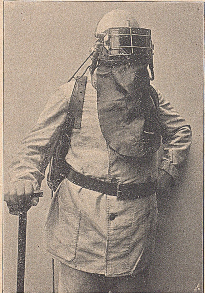
Fig. 30. Helmapparat der Sauerstoff-Fabrik, Berlin, mit Fernsprecheinrichtung.
