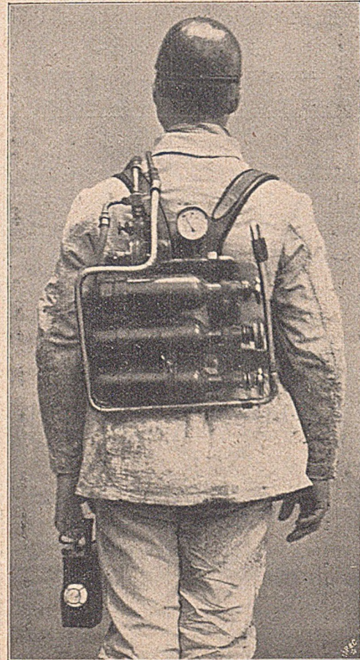
Rückenansicht des Atmungsapparates der Sauerstoff-Fabrik, Berlin, Type 1904 Fig. 13 mit
