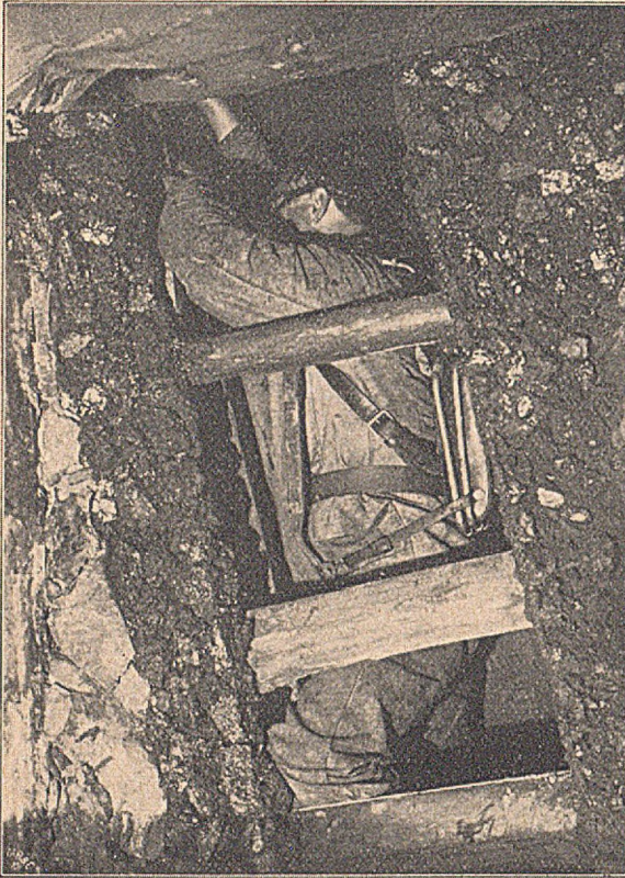
Fig. 18. Befahrung des Überhautens I im Übungsraum für Atmungsapparate auf Zeche Shamrock I/II.
