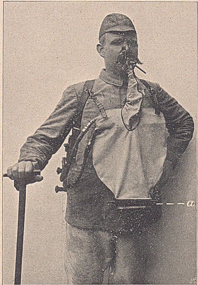
Fig. 25. Atmungsapparat des Trägerwerkes in Lübeck mit Mundstück. Vorderansicht.
