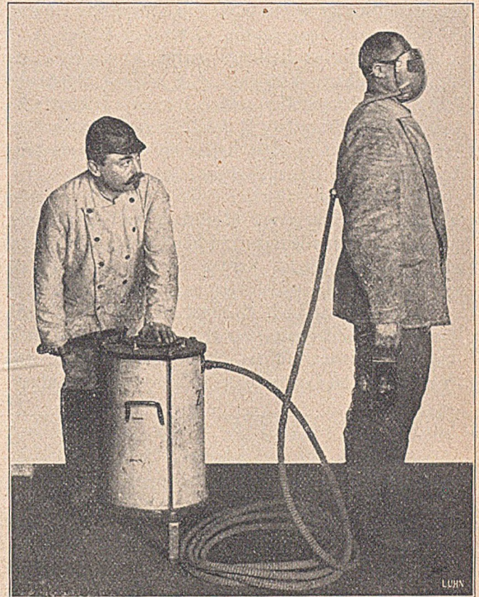
Fig. 36. Blasebalg und Stolzschens Rauchmaske von C. Schramm in Magdeburg.
