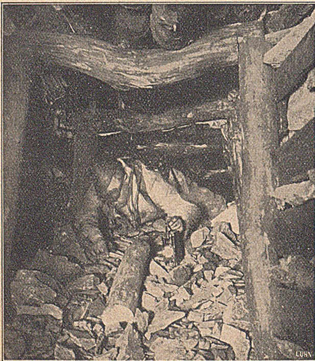
Fig. 19. Hinwegkriechen über den Streckenbruch
