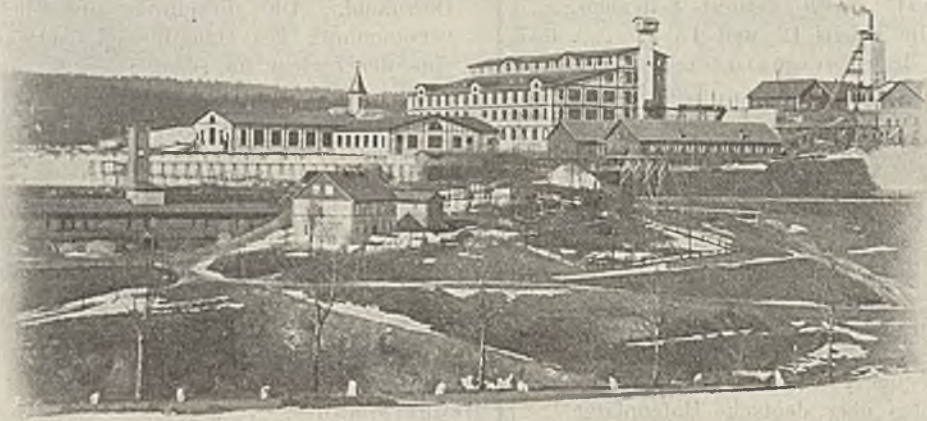
Fig. 1. Gesamtansicht des Ottiliaeschachtes und der neuen Aufbereitung.
