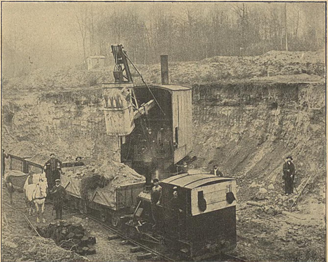
Fig. 8. Bagger bei Seitenentnahme auf kurzem Baggergleis.
