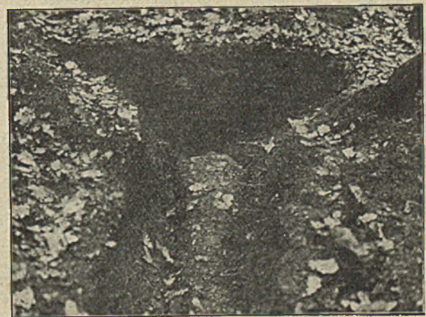
Abb. 16. Dieselbe Grube wie in Abb. 15, in der Längsrichtung gesehen, mit dem gesunkenen Erdblock zwischen den beiden Rissen.
