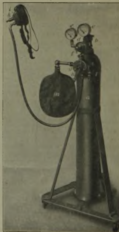
Abb. 10. Wiederbelebungsapparatur nach Dr. Bratsch in ortsfester Ausführung.
