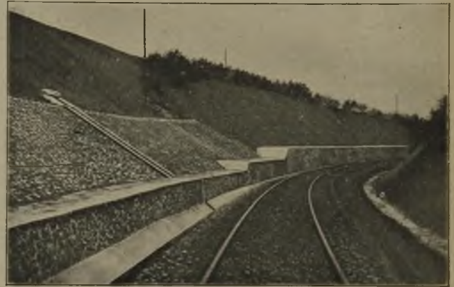
Abb. 2. Verwendung von Hochofenschlacke als Böschungfläche, Stützmauerstein und Gleisbettung.
