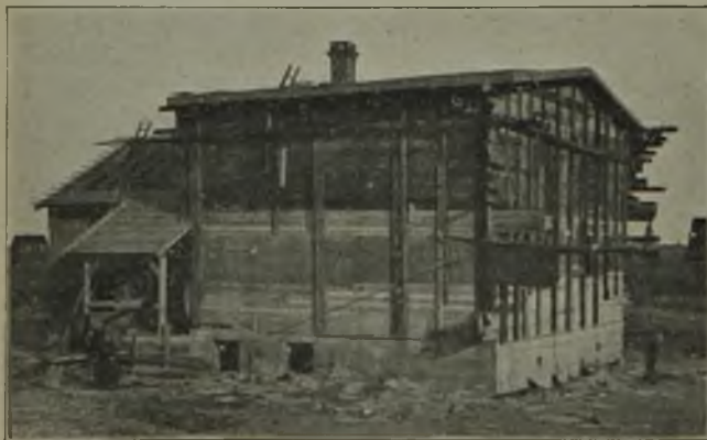
Abb. 3. Arbeiterwohnhaus aus Schlackenbeton in der Schalung.
