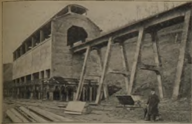
Abb. 5. Kalkspeicher aus Eisenbeton.
