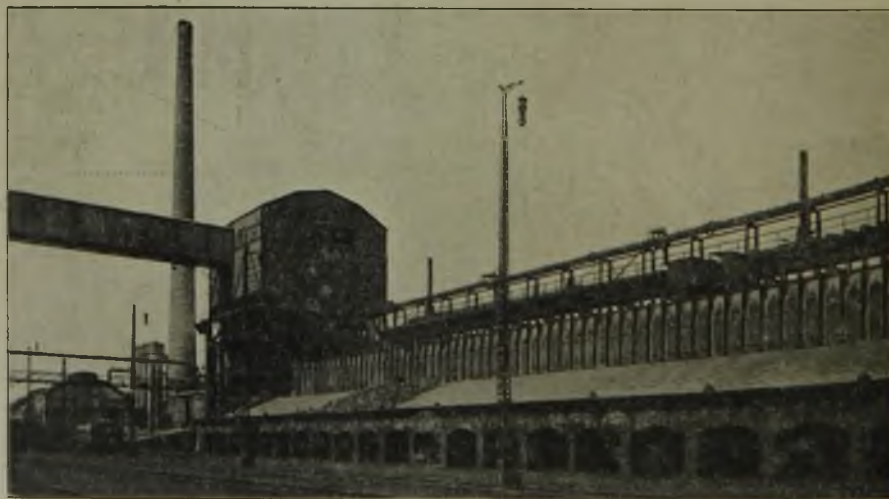
Abb. 11. Koksofenanlage mit geneigtem Koksplatz.
