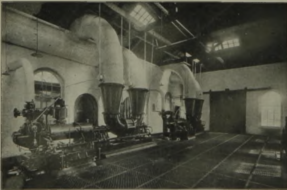
Abb. 26. Kreiselsaugeranlage, Bauart Parsons.
