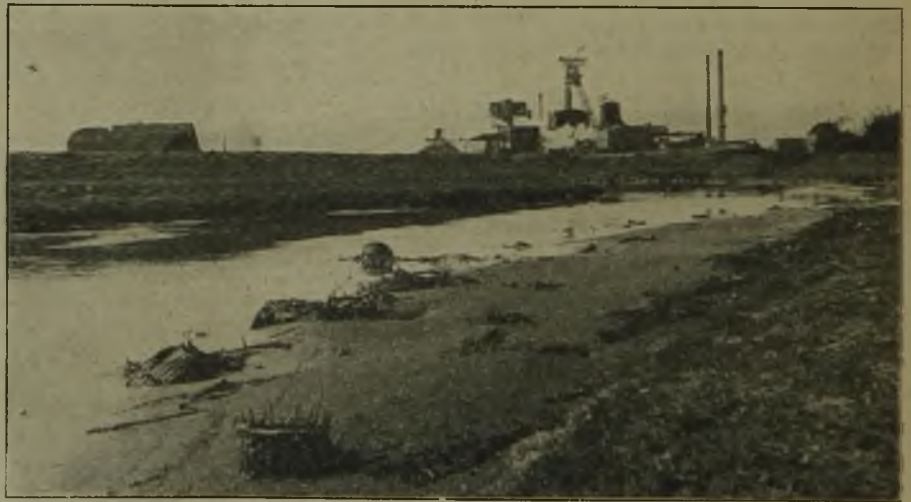
Abb. 5. Die Emscher oberhalb der Zeche Vondern vor der Regulierung.
