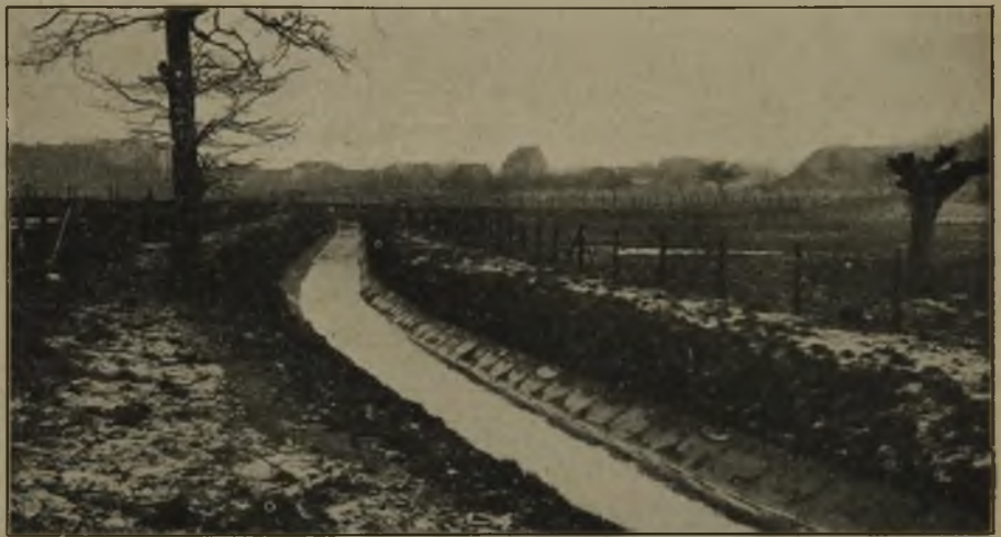
Abb. 8. Die Beek bei Hamborn nach dem Ausbau zu einem offenen Abwasserkanal.
