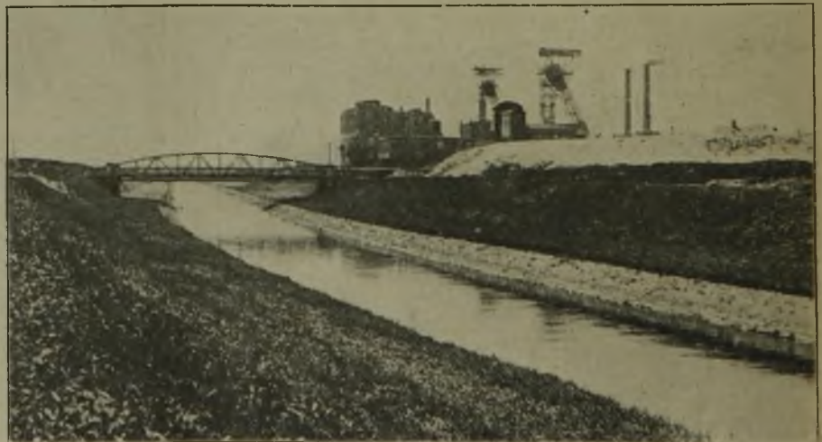
Abb. 6. Die Emscher an derselben Stelle im neuen Bett.
