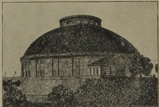
Abb. 9. Ansicht des Pumpwerkes.
