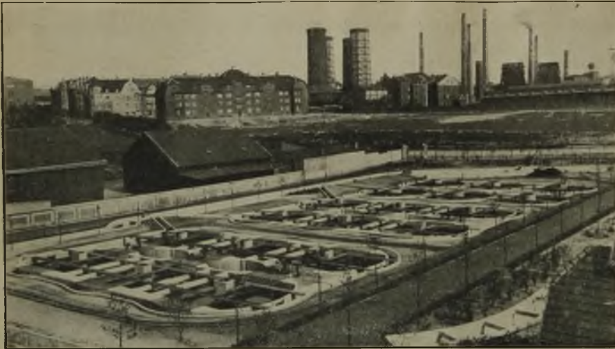
Abb. 22. Kläranlage Essen-Nord für 180 000 Einwohner.
