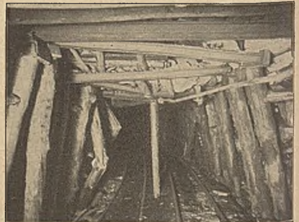
Abb. 4. Früherer Ausbau einer Umbruchstrecke auf der Zeche Viktoria Mathias.
