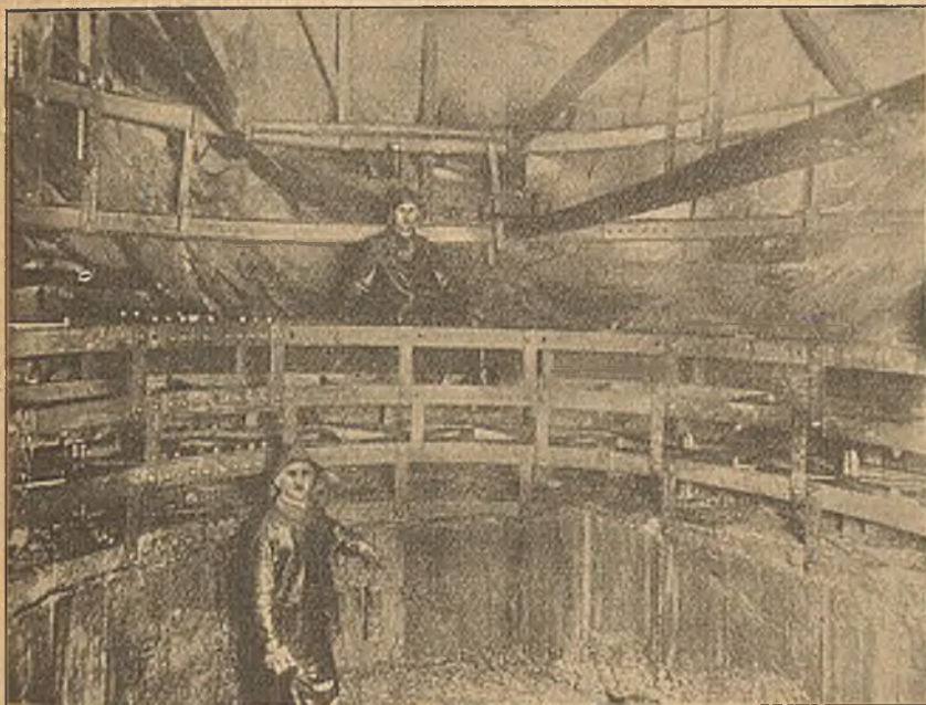
Abb. 10. Breilscher Ausbau im Schacht 1 der Zeche Graf Beust.
