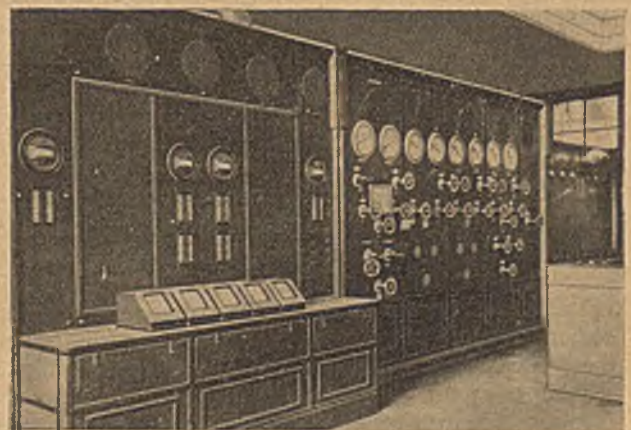
Abb. 14 und 15. Ansichten des Zentralbedienungsraumes, in dem alle Meß- und Reglungsvorrichtungen zur Bedienung der ganzen Anlage vereinigt sind.
