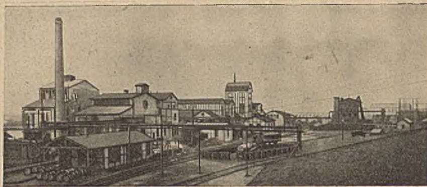
Abb. 16. Ansicht des Hauptteiles der Rheinauer Betriebsanlage.
