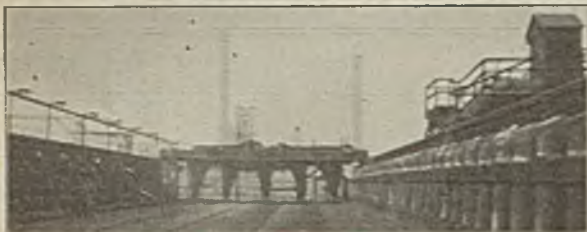
Abb. 9. Auf den Verlängerungen der Ankerständer laufender Füllwagen.
