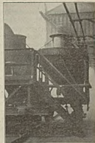
Abb. 8. Fülltrichter mit ausziehbarem Ansatz und oberem Rohrstutzen.
