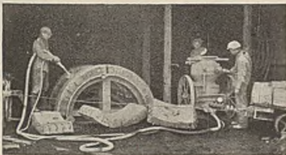
Abb. 3. Herstellung der Torkret-Tübbing.
