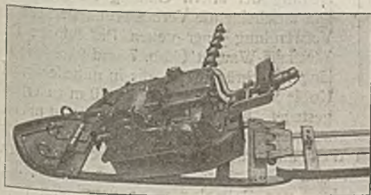
Abb. 2. Höhenverstellvorrichtung.
