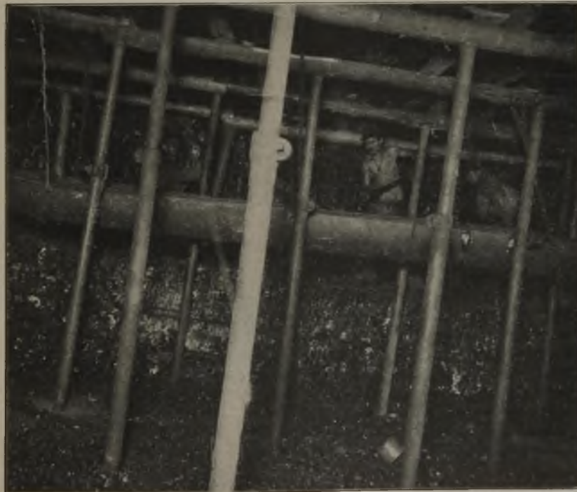
Abb. 1. Ausbau hoher Abbaue mit Eisenrohrstempeln.
