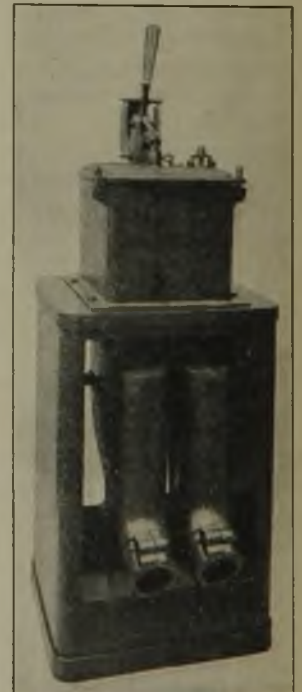
Abb. 4. Trennschalter für Kabelanschluß.
