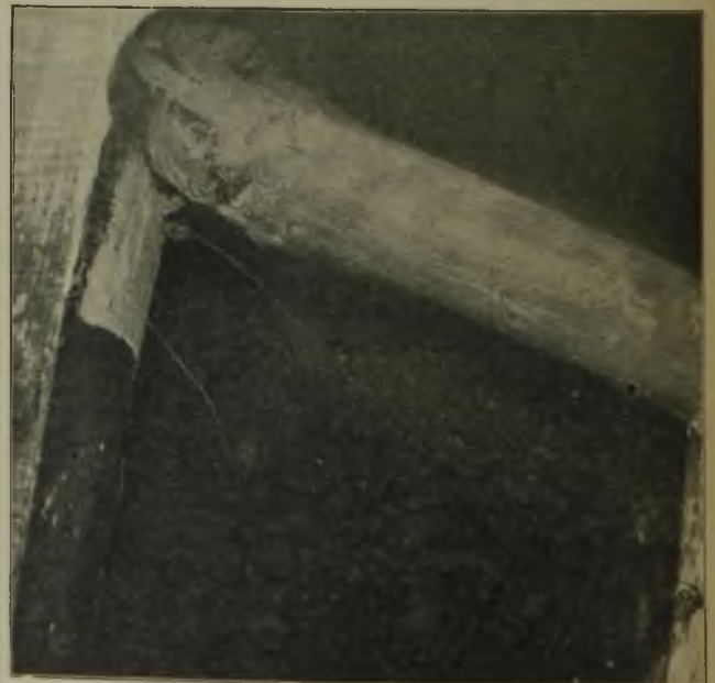
Nach 3 Jahren freigelegter Bergeversatz.
