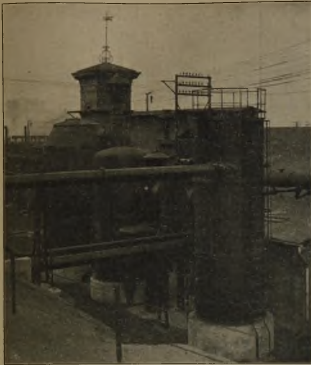
Abb. 11. Gesamtansicht der Kondensationsanlage.
