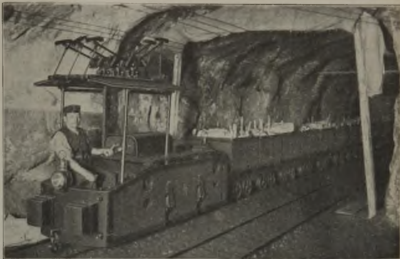
Abb. 3. Drehstrom-Lokomotivförderung in einem Kalisalzbergwerk.
