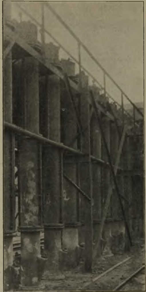
Abb. 2. Steigerohre, in der Längstichtung geteilt und zusammengeflanscht.
