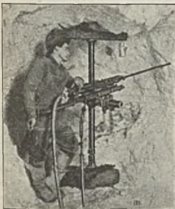
Abb. 9. Denver-Hammerbohrmaschine (Vorschub von Hand).
