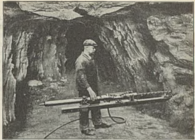
Abb. 10. Bohrhämmer mit pneumatischem Vorschub.
