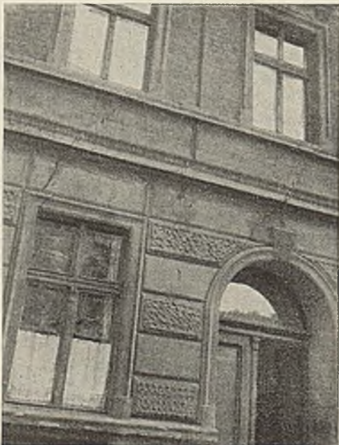
Abb. 18. Haustür des Hauses Werdermannstraße 1 a.
