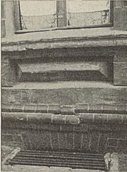
Abb. 17. Kellerfenster des Hauses Werdermannstraße 1 a.
