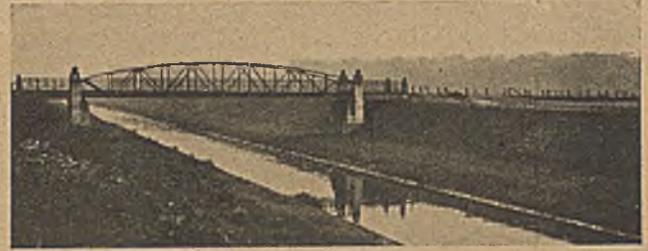
Abb. 6. Der Wasserspiegel ist 3,5 m gesenkt und das Gelände entwässert. Überschwemmungen sind ausgeschlossen.
