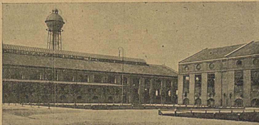
Abb. 9. Vorderansicht des Kauen- und Magazingebäudes sowie eines Fördermaschinengebäudes.
