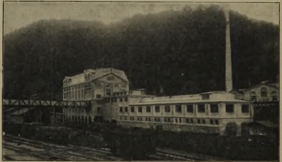
Abb. 8. Ansicht der Separation und Wäsche in Peißenberg.
