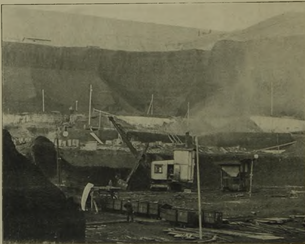
Abb. 1. Mit Dampf betriebener Löffelbagger im Tagebau der Braunkohlengrube Concordia bei Nachterstedt.
