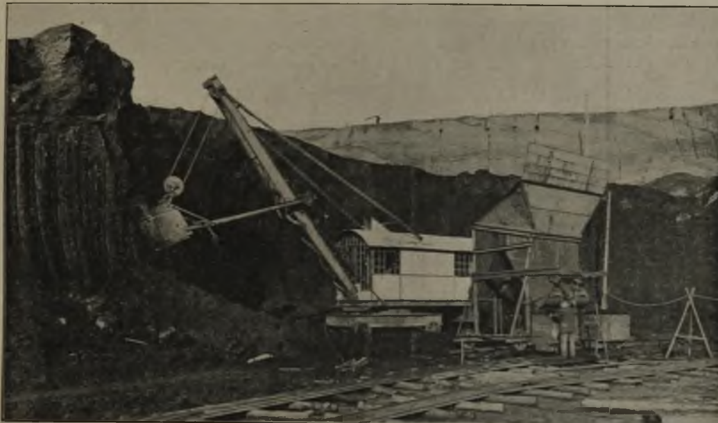
Abb. 2. Elektrisch angetriebener Löffelbagger der Rositzer Braunkohlenwerke im Tagebau Germania bei Gorma.
