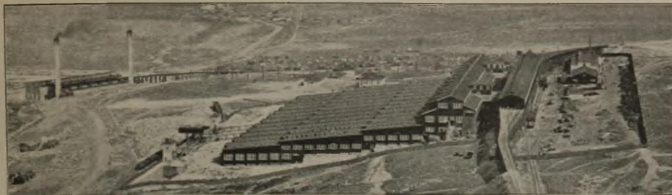
Abb. 48. Die neue »Magna«-Aufbereitungsanlage der Utah Copper Co.
