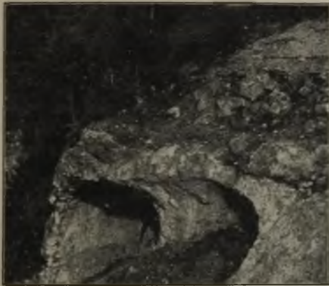
Abb. 20. Höhlungen im Dolomit von Sala (Wirkungen des Feuersetzens).
