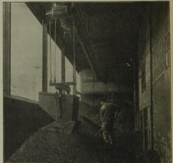
Abb. 14. Elektrohängebahn für kleine Förderleistung.
