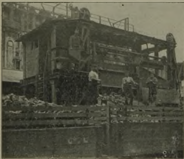
Abb. 27. Verlademaschine auf dem Stahlwerk Cargo Fleet in Middlesbrough. Der Behälter ist zum Verladen hochgezogen.
