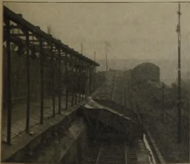
Abb. 26. Verladeanlage der New Brancepeth-Grube.
