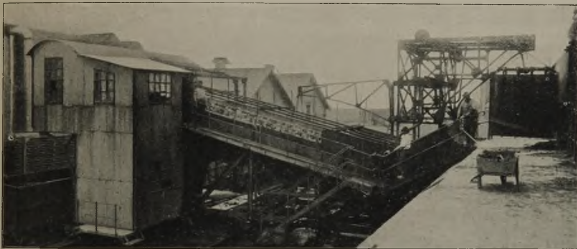
Abb. 36. Fahrbare Verladeanlage auf der Kokerei der Mines de Béthune in Bully les Mines (Pat. Méguin).
