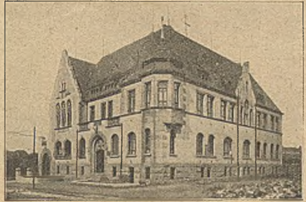
Abb. 1. Ansicht des Gebäudes.
