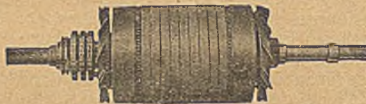
Abb. 2. Anker des Wasserhaltungsmotors.
