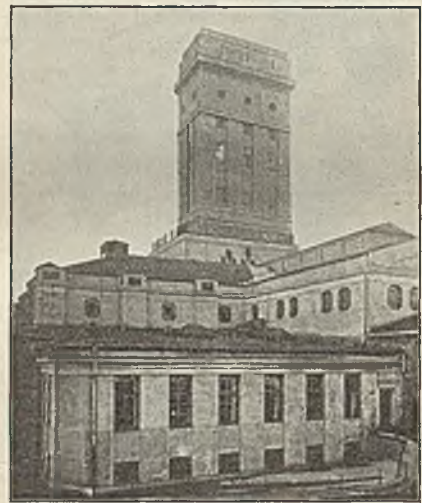
Abb. 4. Breitseite des Förderturms auf der Grube Vereinigtfeld.
