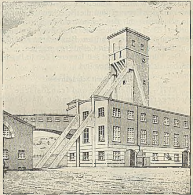
Abb. 10. Ansicht des Fördergerüsts auf dem bayrischen staatlichen Steinkohlenbergwerk in Peiting.
