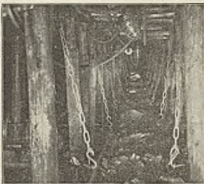
Abb. 8. Ort feste Abbaubeleuchtung.
